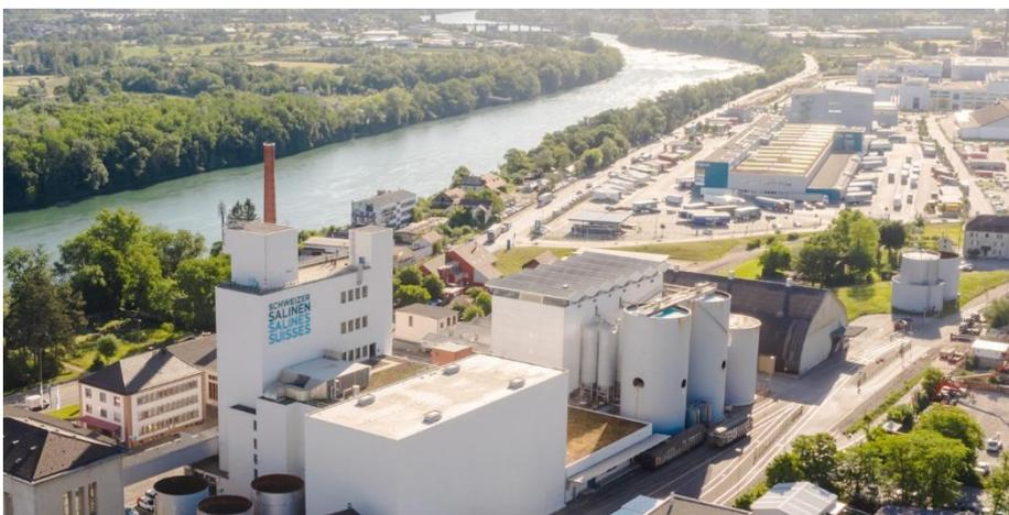
die Verdampfer-Anlage und die Kompressoren zu besichtigen. Hier wird die Sole erhitzt, bei 128°C kristallisiert das Salz. Es ist ein kontinuierlicher Prozess, Verdampfer und Dampf-Kompressor laufen 10 Tage rund um die Uhr, werden danach abgekühlt und gereinigt und durchgespült. Wir
